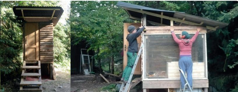
Die Planung der Komposttoilette war sehr aufwändig. Maja hat für die praktische Umsetzung eine Konstruktion entworfen, die sich an den vor Ort verfügbaren Materialien orientierte. Beim Bau der Toilette hat sie versucht, ausschließlich Recyclingmaterialien zu verwenden. Auch in Zukunft werden Naturschutzfachkräfte gefordert sein, unter den jeweils herrschenden Bedingungen die effizienteste Lösung zu finden.
